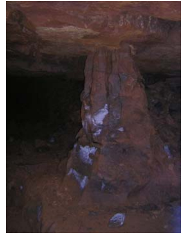
(e) 剥離して細った残柱
