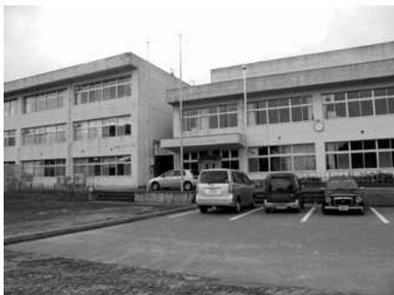
写真3 自然学校に生まれ変わった旧小泊小学校
