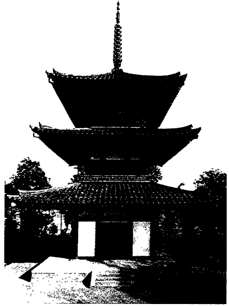
図2 法起寺三重塔
