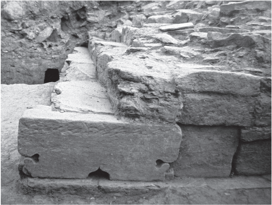
図4 仏塔階段側面
