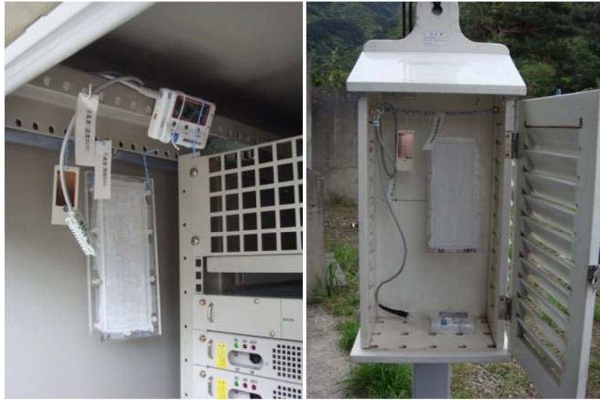
図 8-14 調査状況の写真
