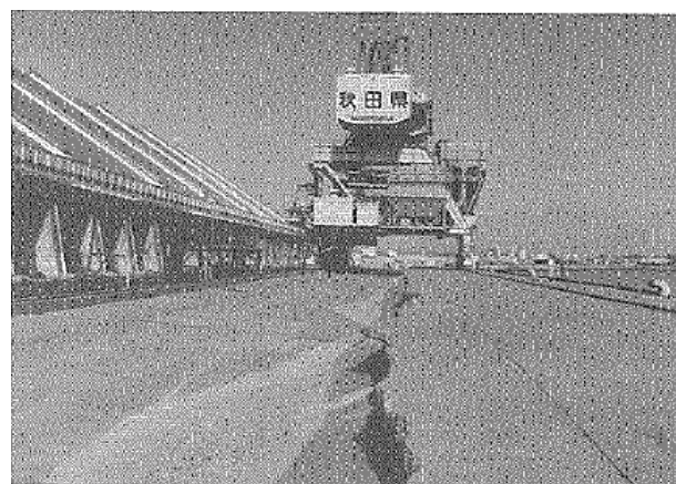
写真-2.3 秋田港外港地区-13 m 岸壁での矢板式岸壁の被害状況 9)
