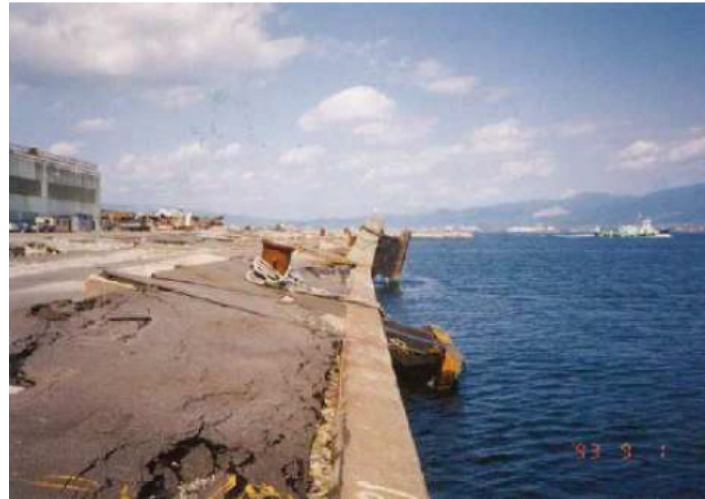
写真-2.2 函館港弁天地区-8 m 岸壁での矢板式岸壁の被害状況 9)
