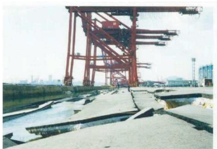
写真-2.4 神戸港での重力式岸壁の被害状況 5)
