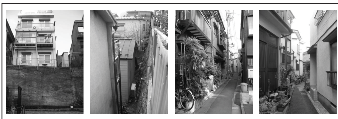
図3-1. 若葉地区における崖地（左側）と路地（右側）
