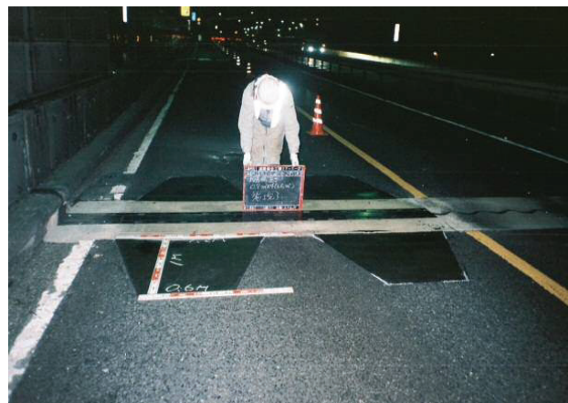
図-4.2.5 段差擦付工
