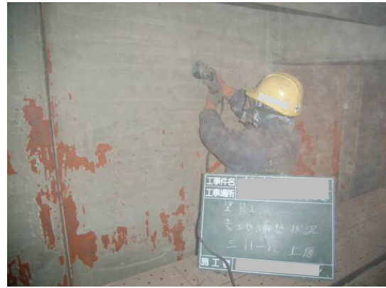
鋼桁素地調整(2)
