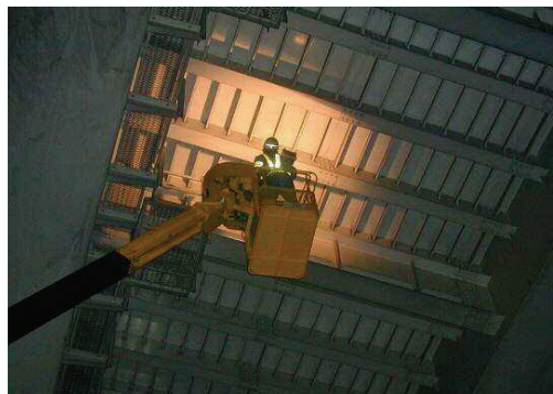
機械足場による接近点検(2)
