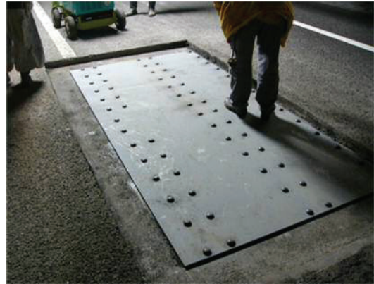
デキプレートの当板補強
