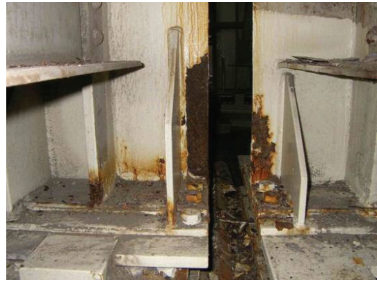
図-4.3.4 桁端部の腐食 (Aランク)
