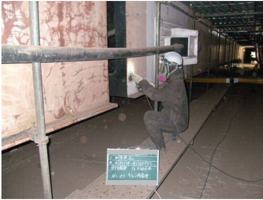
鋼桁素地調整(1)
