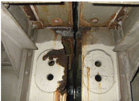
図-4.3.4 桁端部の腐食 (Aランク)
