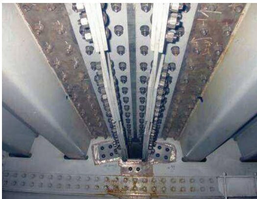
鋼床版リブ取替（大）
