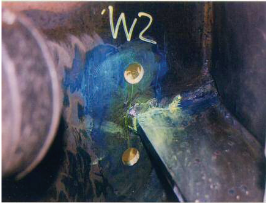
ストップホール（応急処置）
