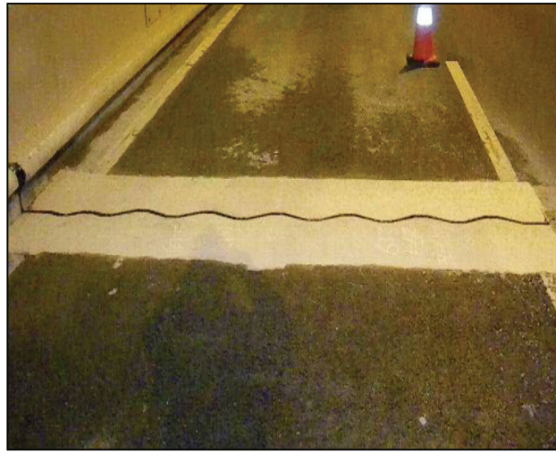
図-4.2.4 伸縮装置部の後打ちコンクリート
