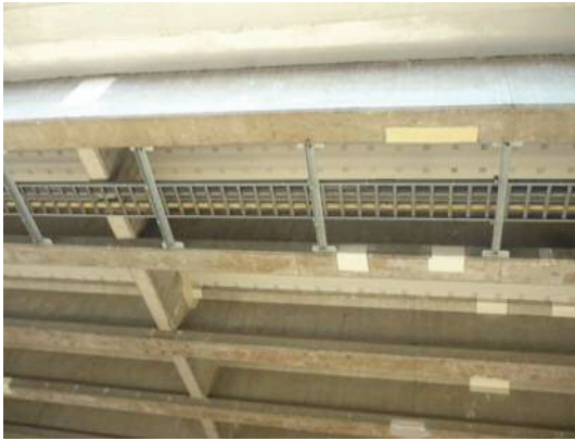
桁剥落防止（部分）
