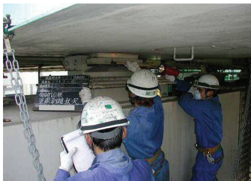
吊足場内での接近点検(2)
