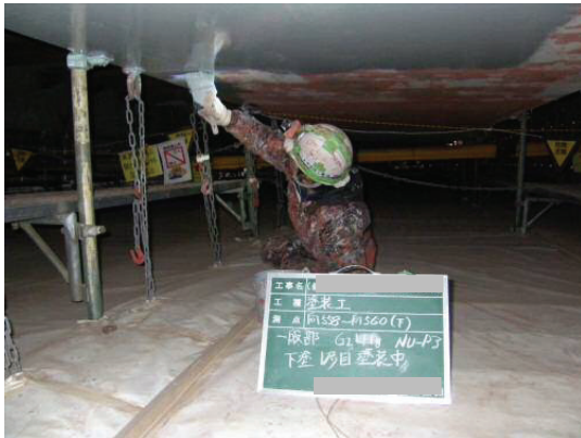
鋼桁塗替塗装(1)
