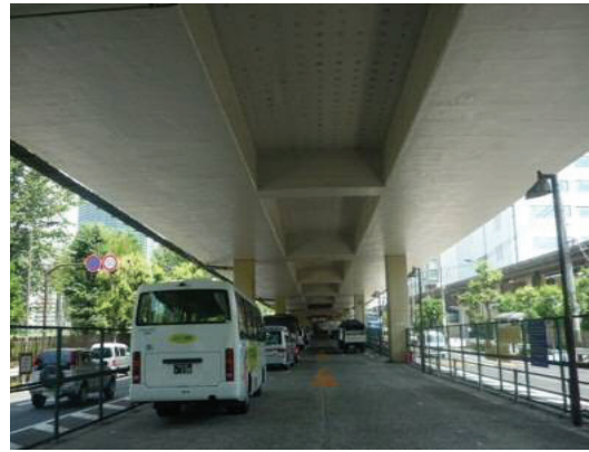
桁剥落防止（全面）
