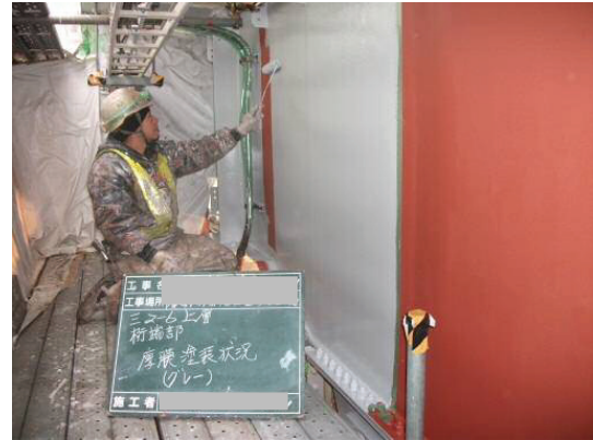
鋼桁塗替塗装(2)
