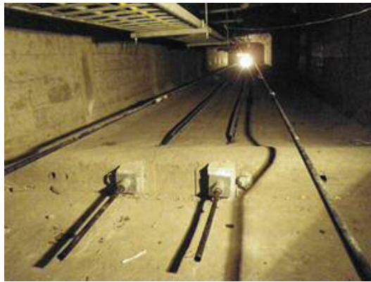
外ケーブル工法
