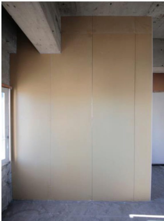
写真 4.18 ボード材の出来形
