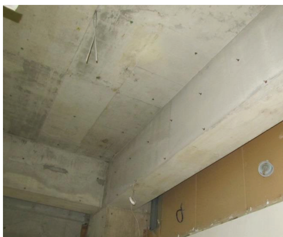
写真 2.9 鉄筋コンクリート躯体の天井部分
