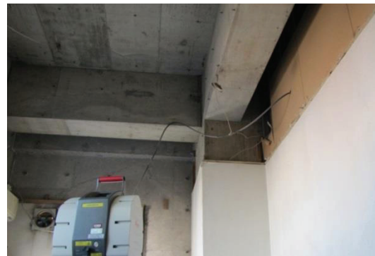
写真 4.4 配線コード、天井下地等の雑下地材の 残存状態
