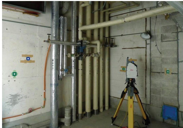
写真 2.3 計測対象の機械室
