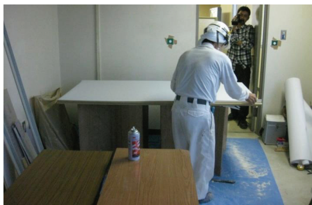
写真4.15 せっこうボードのプレカット部材の作成の様子
