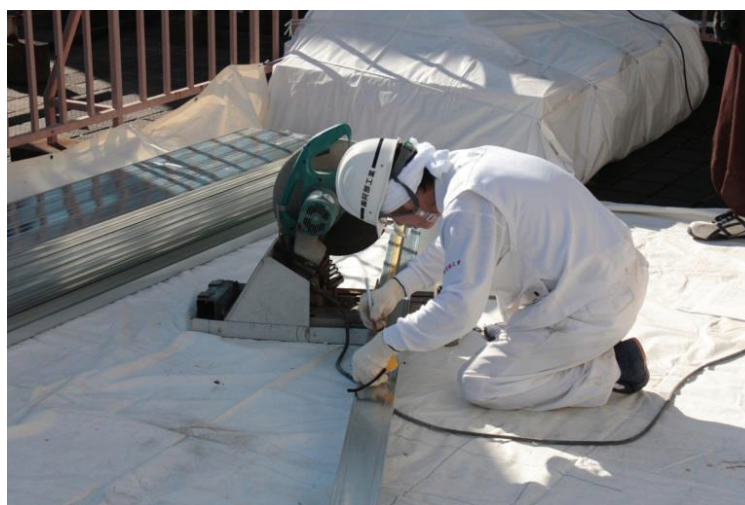
写真 4.8 スタッドの切断の様子
