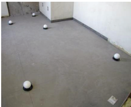
写真 4.3 通り芯に設置した地墨取得用球ターゲット
