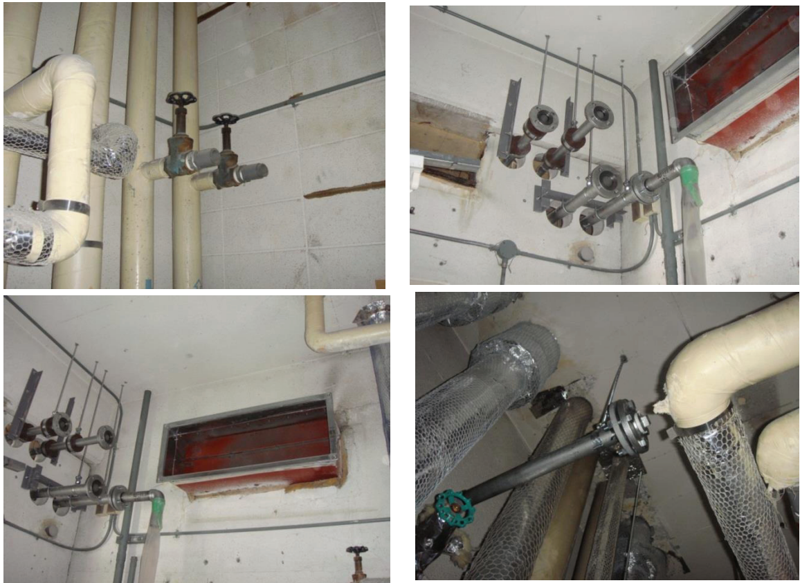
写真 2.4 配管とダクト類の接合部
