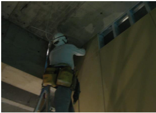
写真 4.16 天井に接するボードの取り付け
