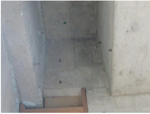
写真 4.22 取り付け前の躯体
