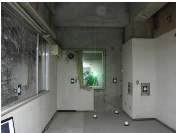
写真 2.8 計測対象の鉄筋コンクリート躯体
