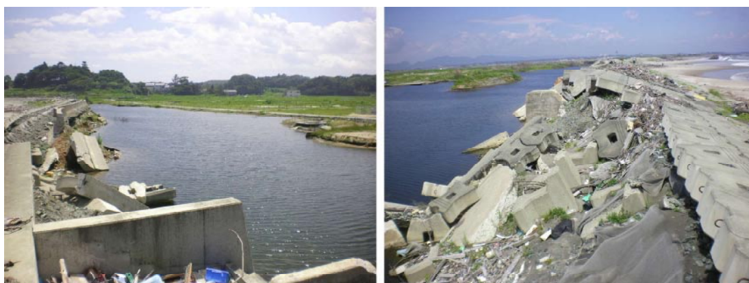
図-4.11 相馬市磯部における海岸堤防被害の状況(落堀と被覆ブロック流失部)
