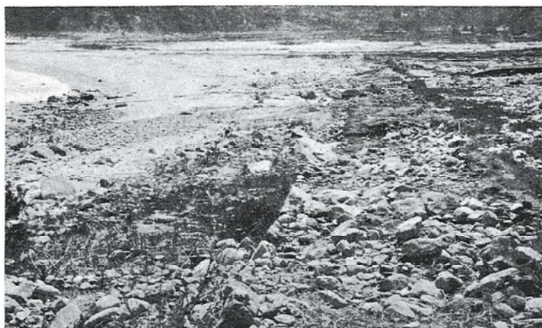
寫眞第四十五 氣仙郡吉浜村。明治 29 年の津浪の被害甚大なりしに依り築造した防浪堤(断面底巾 9.8 m, 天端巾 2.7 m 高さ最大 5.5 m 海に面する側は 3 分勾配にて間知積の土堤)は今回の津浪で全部流失。寫眞は長さの方向に撮つたもので右方に一部基礎部分の残を見る。
