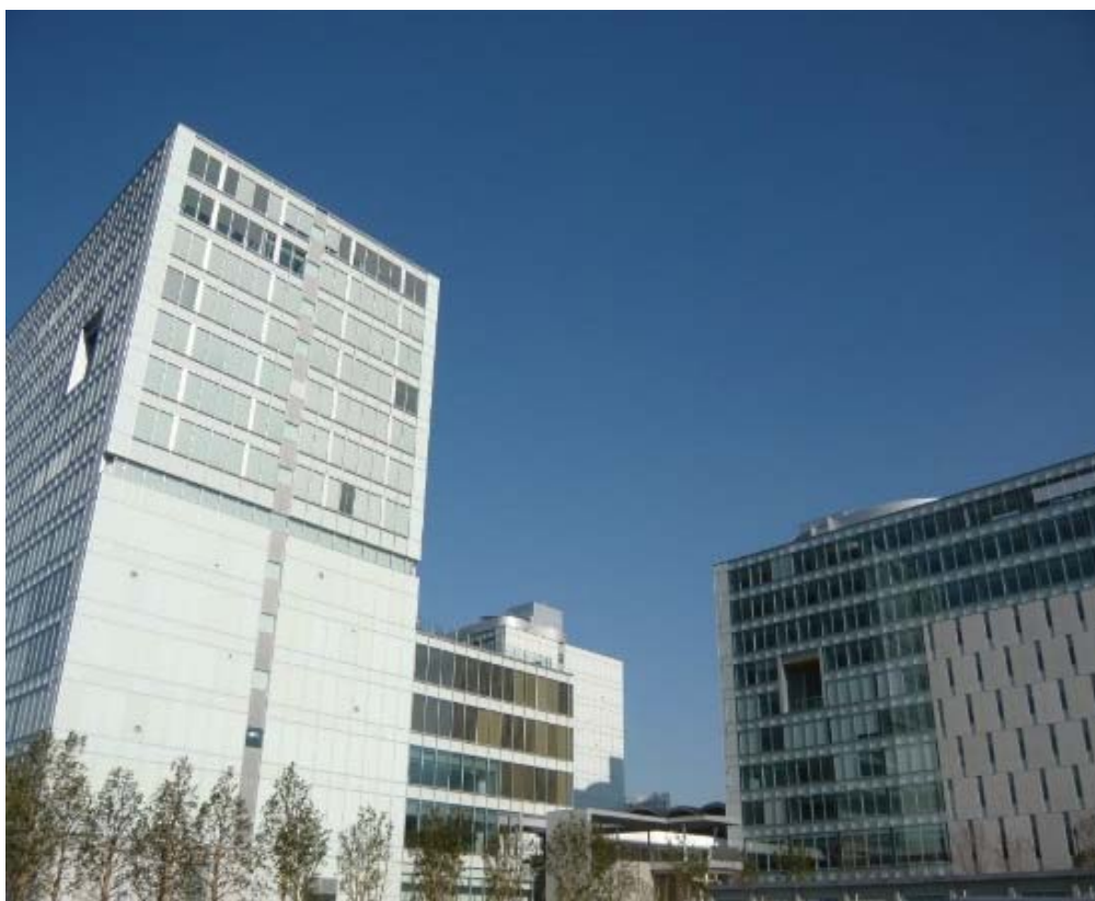
Photo 4.2-1 建物 A（写真左側の建物）および建物 B（写真右側の建物）
