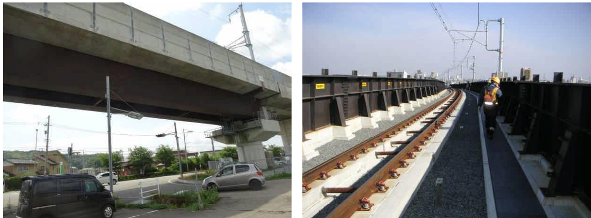
図 2-5 鋼・複合橋（合成桁）の例
