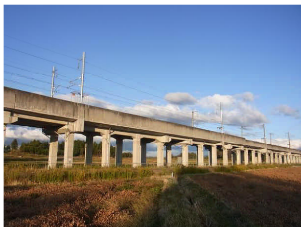
(a) ラーメン高架橋
