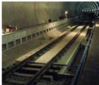
(c) 軌道構造3 フローティングスラブ軌道 3-2)
