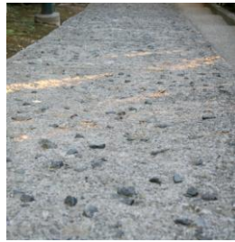
凹凸20mm, 傾斜7deg
