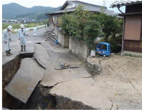
写真 5. 4 垂炭廃坑による陥没
