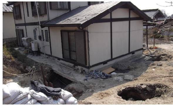
写真5. 7 亜炭廃坑の地震による陥没<sup>17)</sup>
