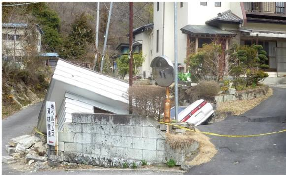
写真5. 6 地下採石場立坑跡の地震による沈下<sup>17)</sup>
