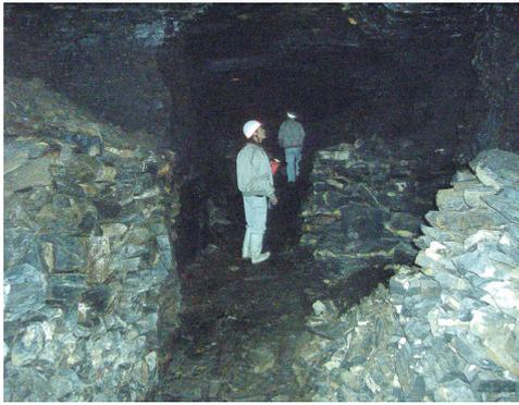
写真 5. 2 垂炭廃坑内部の坑道とぼた
