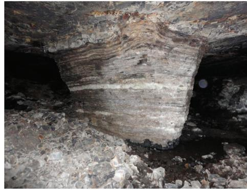
写真 5. 3 垂炭廃坑内部の残柱
