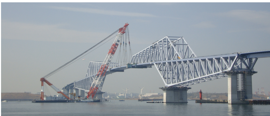
図-1.1 東京ゲートブリッジ中央径間架設時 (2011. 2. 17)
