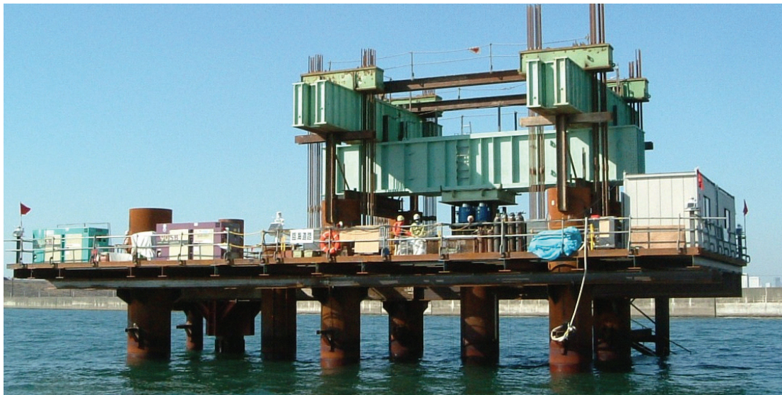
図-3.6 押込み試験状況
