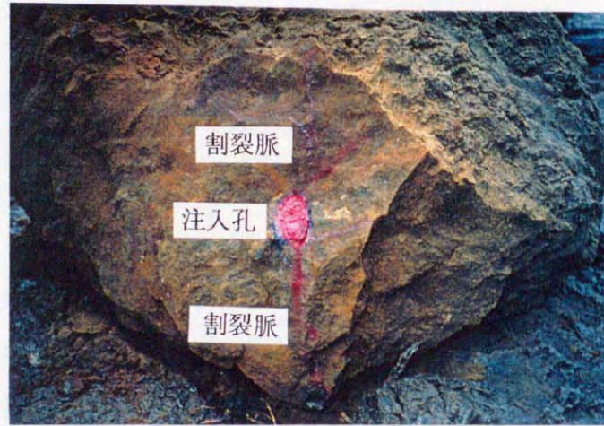
写真-5.4.4 パッカー用瞬結性薬液の注入状況
