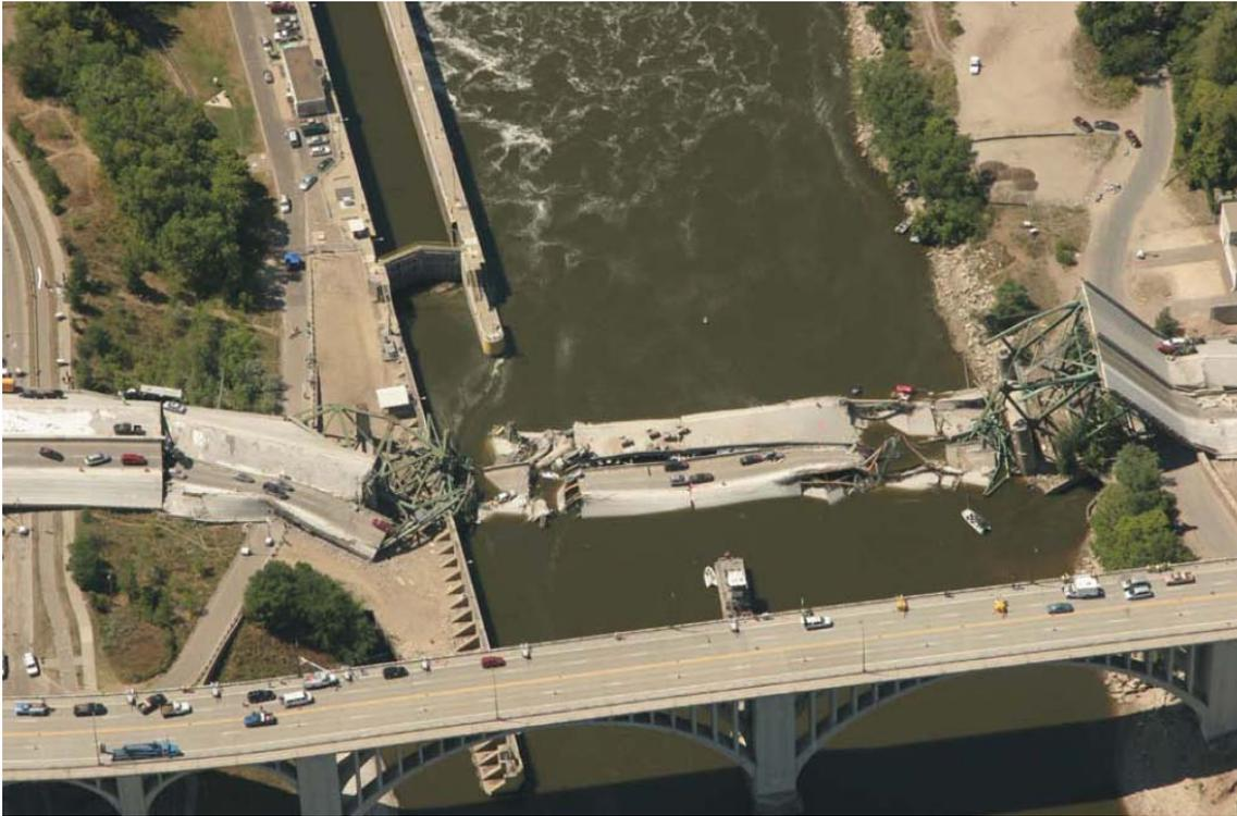
図-4.2 崩落した後の I-35W 橋
