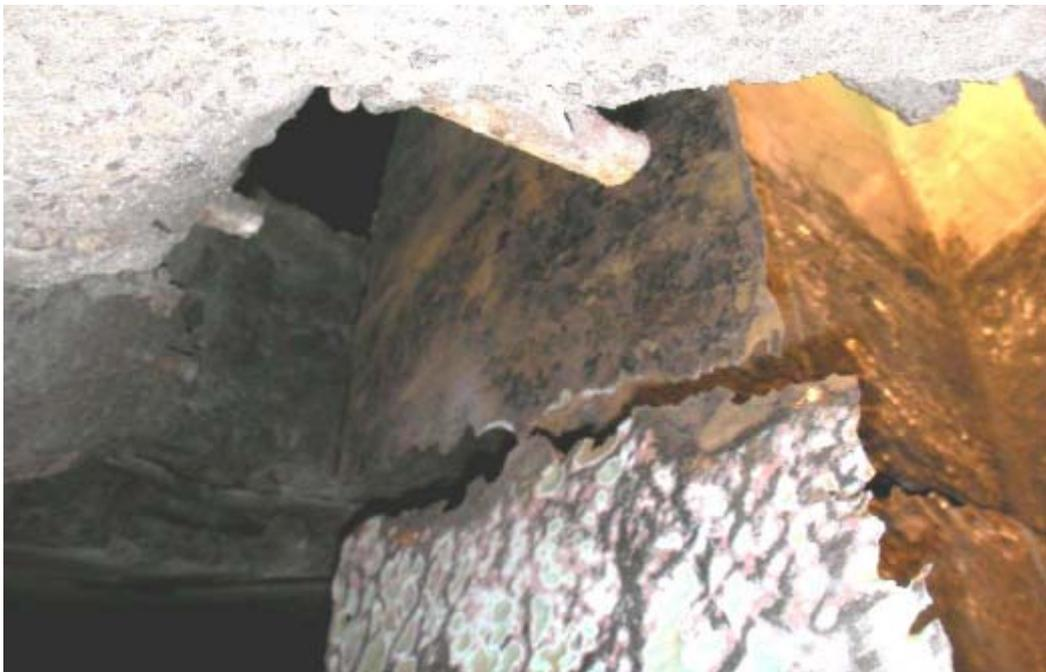
図-1.4 木曽川大橋の斜材の破断状況（出典:国土交通省）
