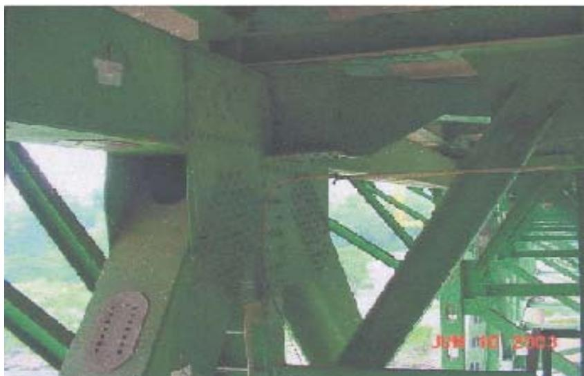
図-4.16 U10 ガセットプレートの面外変形(出典：NTSB<sup>4,18)</sup>)
