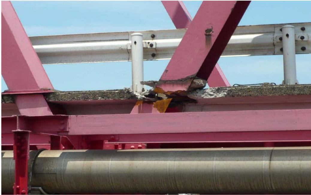
図-1.3 木曽川大橋の斜材の破断状況（出典:国土交通省）
