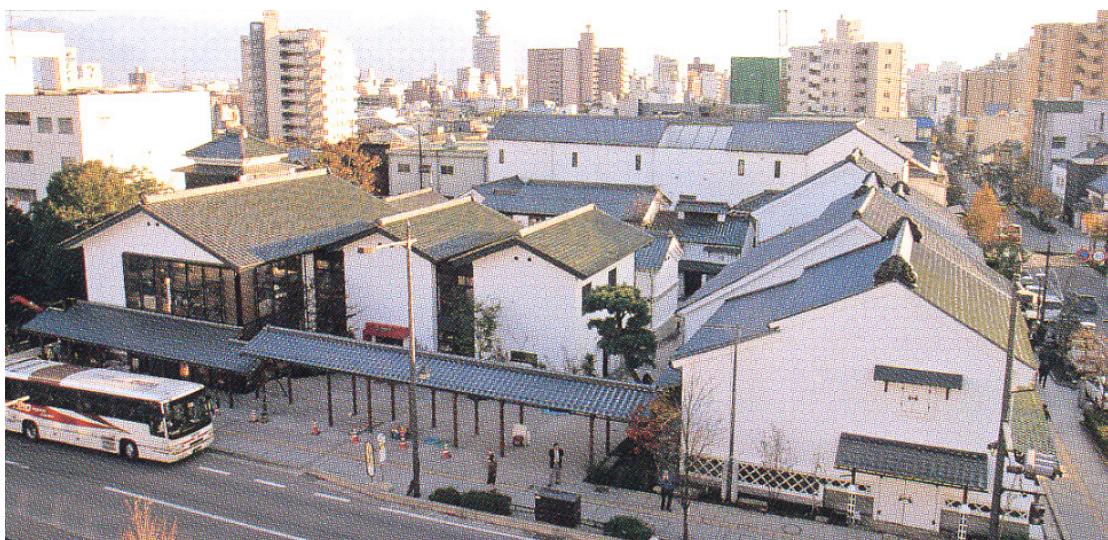
図 1-9 : 全体整備状況 注9)
