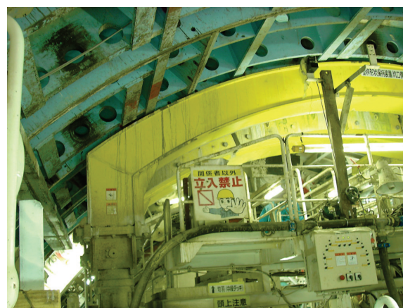
写真-4.4 内型枠の形状保持装置
