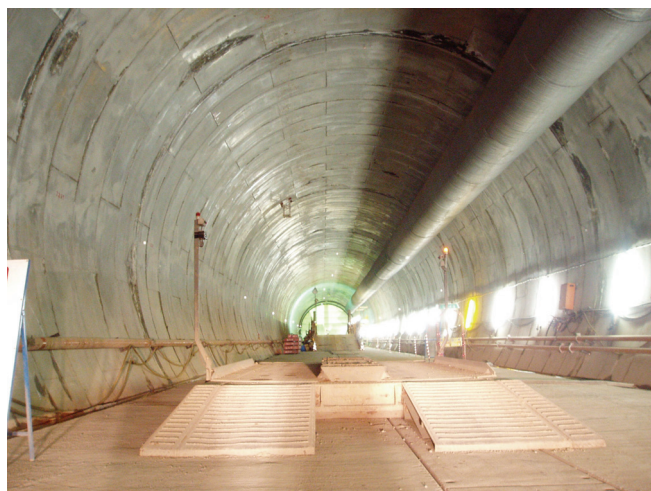
写真-4.11 一次覆工完了後のトンネル
