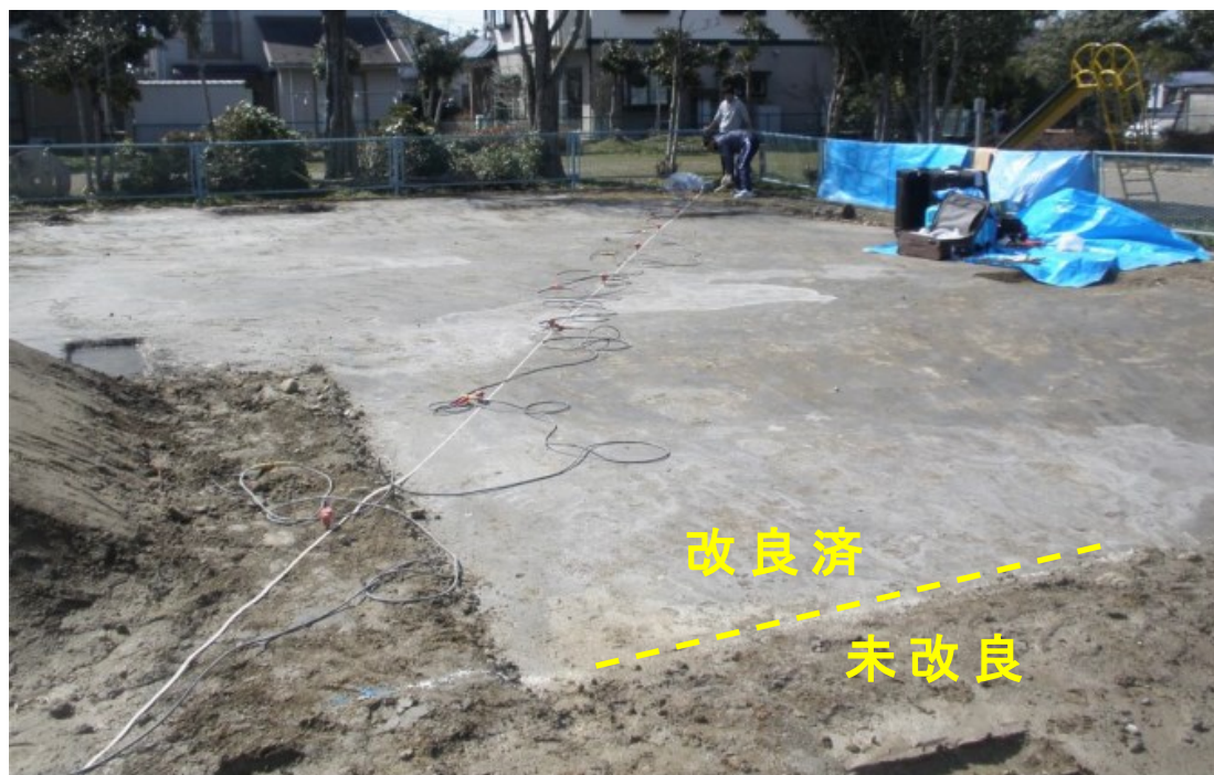
図 2-10 低層住宅建設のための地盤改良工事一例 （富山県富山市，筆者が修士学生時代に所属した研究室の助教の 実家の再建築現場）
