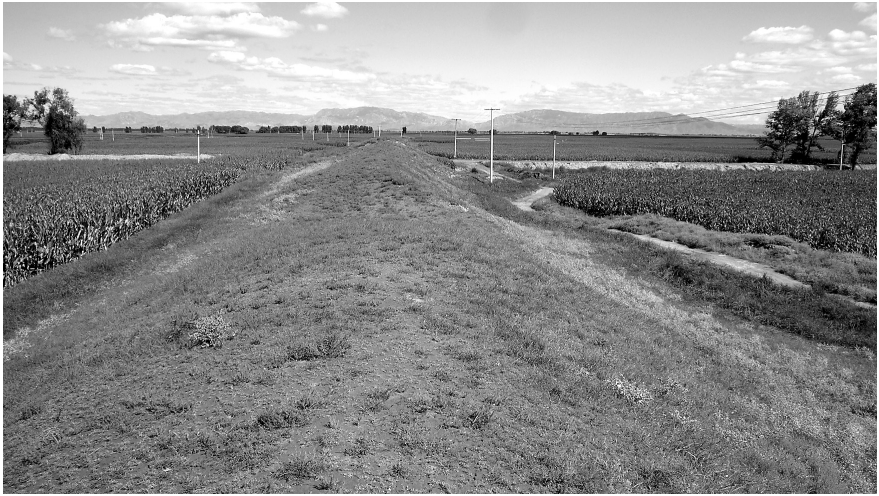
[写真5] 古城村城址西牆（北へ向かって撮影）
