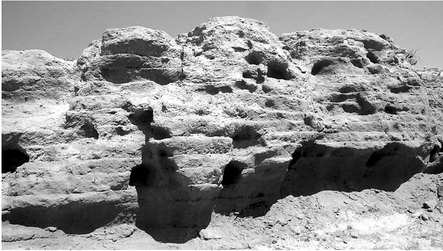
[写真16] 麻池古城② (版築)
