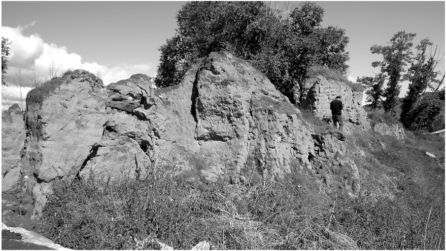
【写真2】三道宮城址西城東牆外側
