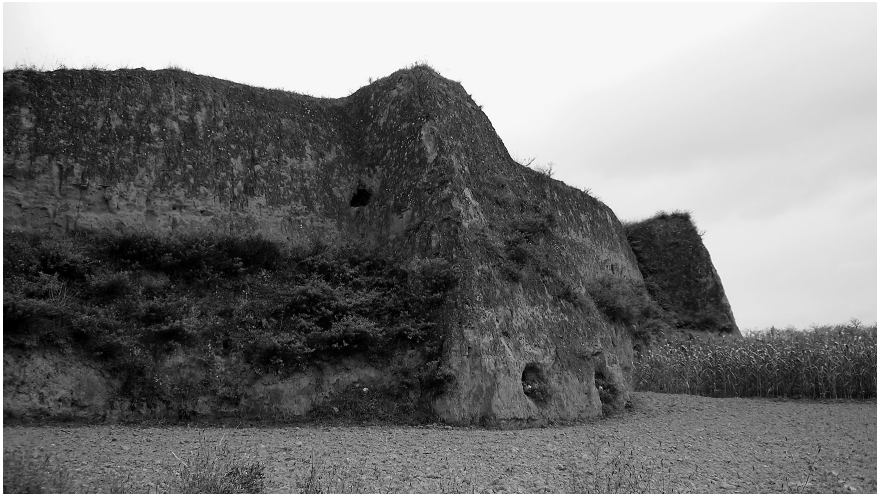
[写真10] 観陣堡 北西牆外側
