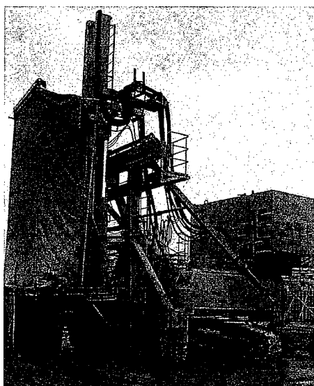
TRD マシンによる掘削
