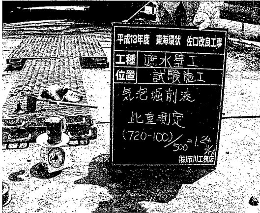
図 7.6 単位体積重量測定状況
