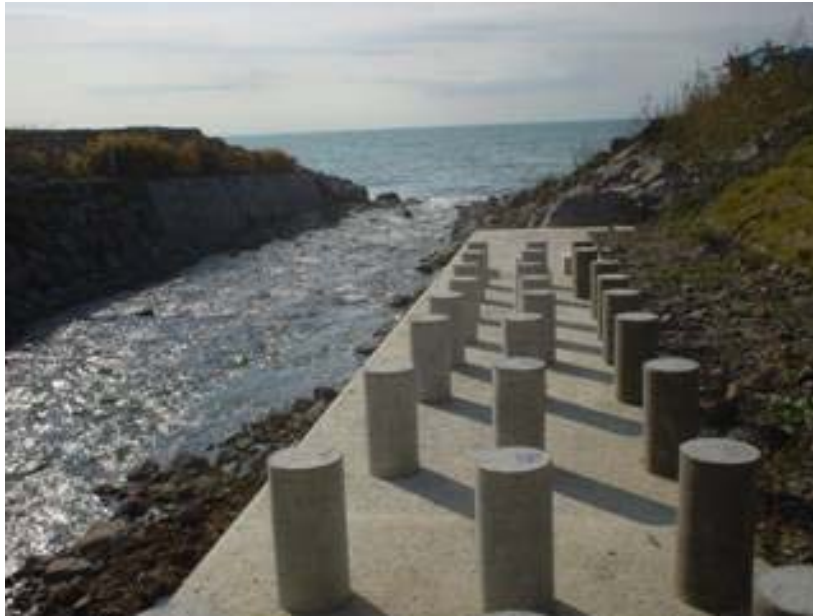
写真 6.4.1 供試体設置箇所の状況
