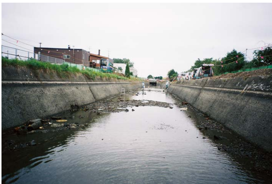
写真 3.2.1 対象構造物の状況の一例
