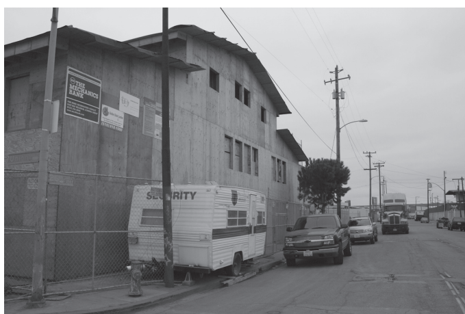
写真 7-7 工事中の OAKLAND NOODLE FACTORY
