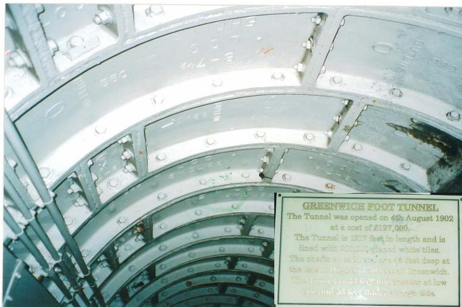
図 - 1.5 ロンドン，グリーンウィッチの歩行者用トンネルのねずみ鑄鉄製セグメント
