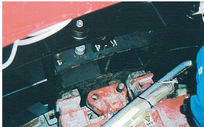
半径方向の移動が終わると，アンカージョイントのハウジングが嵌合する直前まで K セグメントを坑口側に移動する．この時点で，さらにピッチングおよびローリング調整を行う．最後にシールドジャッキにより一気に坑口側に押し込み，組立てを完了する．
