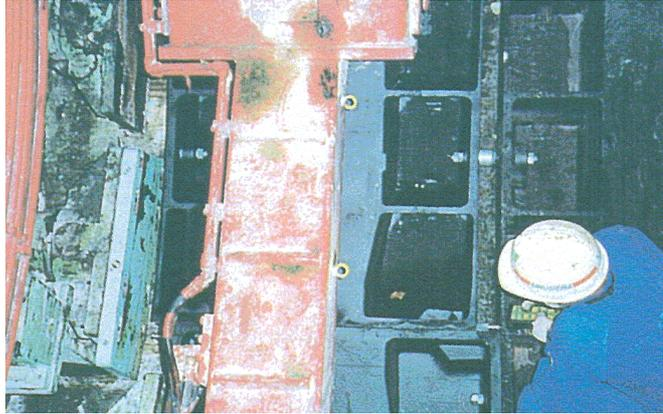
組立てられるセグメントがエレクターの摺動ジャッキにより坑口側に移動される。
