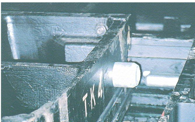
坑口側のリング継手面に取り付けられたハウジング
