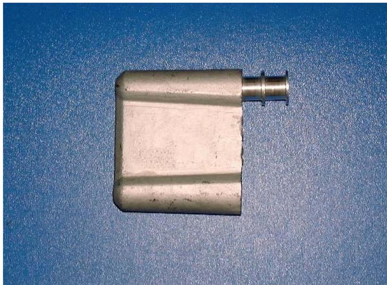
図 - 4.19 バックアップ材を取り付けた AS 金物の写真
