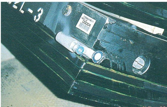
AS ジョイントと切羽側のリング継手面に格納されたスリーブ
