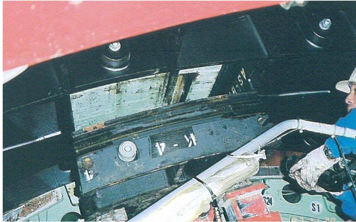
K セグメントの組立て．隣接する B セグメントとの両間隔をよく見ながら K セグメントを半径方向に移動させる．既設リングとの間隔は 150mm 程度空けてある．
