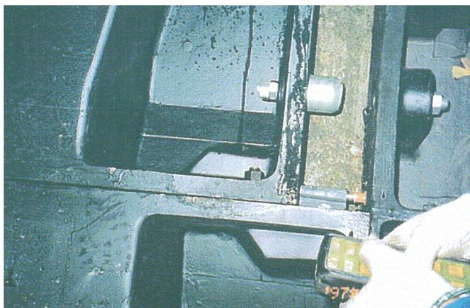
既設セグメントに接触させ、セグメントの高さ位置、ヨーイングなどの位置合わせを行う。
