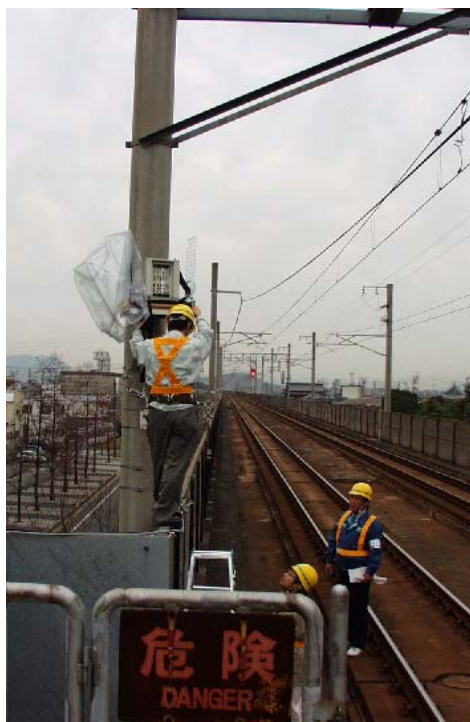
図 7-2-18 丸亀駅構内に設置の 25GHz 帯無線 LAN 基地局を設置中の著者 (予讃線下り方向, 線路面から 3.5m の高さに設置)
