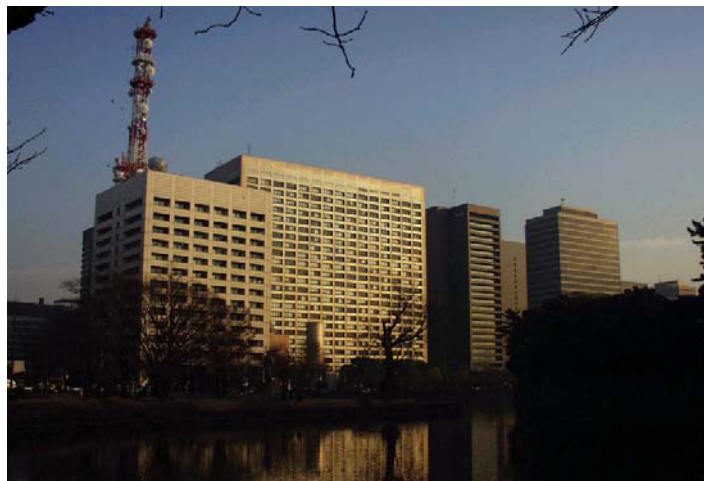
図 A6-4-29. 東京消防庁（左：東京消防庁，右手奥が東京駅方向）
