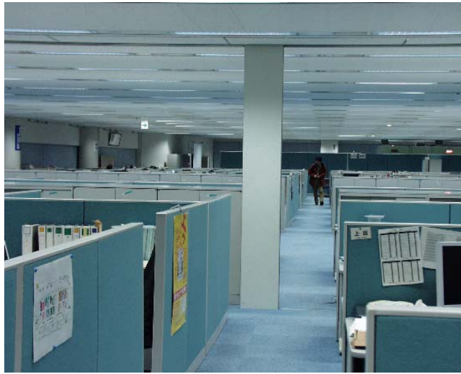
図 7-1-6 屋内伝搬試験にて伝搬に支障を与えたと推定される防火シャッタガイド (幅:309mm 厚み 140mm, 鉄製)
