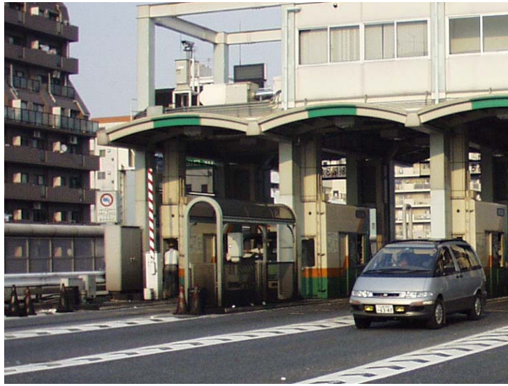
図 A6-4-26. 首都高速道路錦糸町料金所(左側ゲートが ETC)
