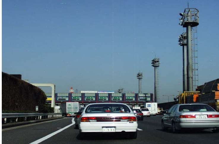
図 A6-4-27. 首都高速道路大井料金所(両側ゲートが ETC)
