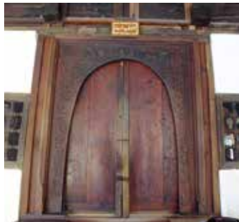
21. 同、フェンフシの大モスクの東入口、アーチ型の木枠内に引き戸が設けられる
