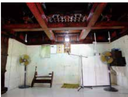
15. 同、イハヴァンドゥーの大モスクの礼拝室、キブラ壁は珊瑚石の白壁
