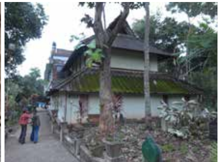
36. 同、コッラム郊外の伝統的モスク、木造で傾斜屋根を架ける
