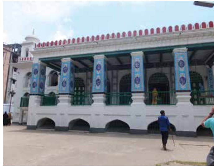
写真⑬ 改修後のイマームバーラー。イラン様式のブルータイルが印象的(2014年撮影)
