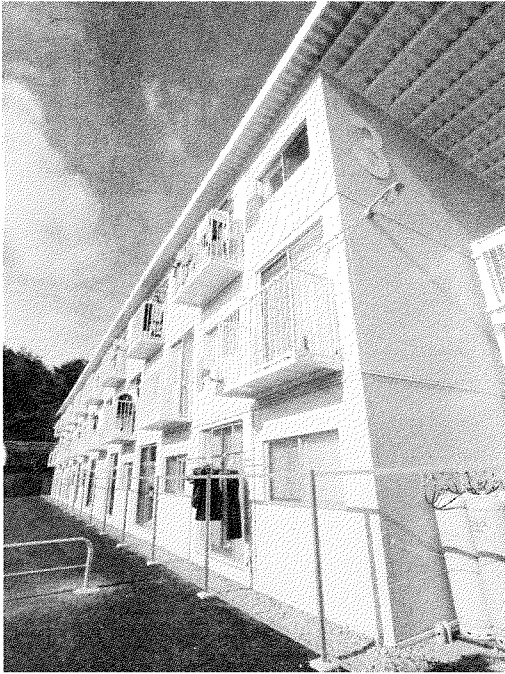
図5：3階建ての仮設住宅の事例（女川町）
