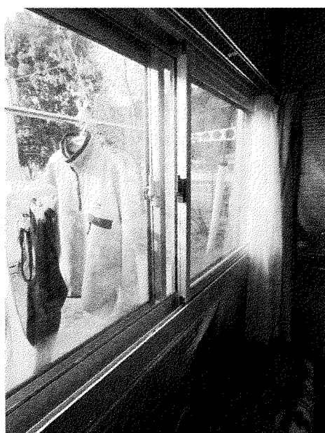
図3：二重サッシおよび窓下の断熱シートの設置例
