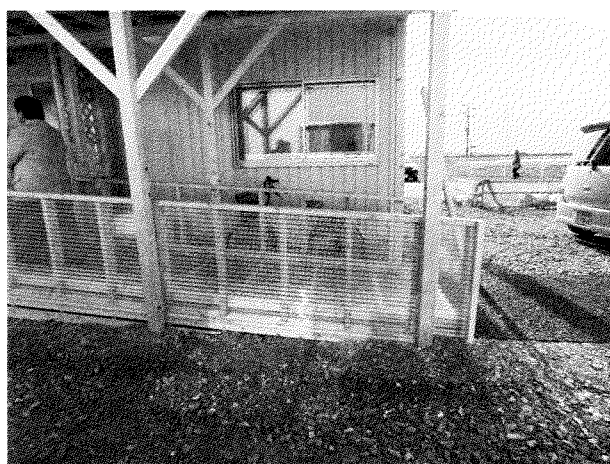
図4：車いす用のスロープおよびアスファルト通路を設置した例
