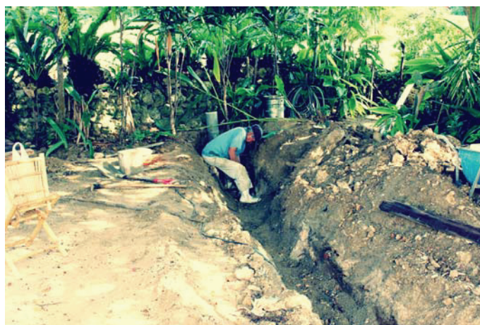
図3 「低い島」の景観——琉球石灰岩と珊瑚の乱積み 上は、削岩機を用いた排水管の埋め込み作業(竹富島のアイノタ集落内)。石灰岩地質の土地を掘り起こすのは、たとえ削岩機を用いても難渋を極める。後ろに見えるのは、珊瑚の乱積み。防風機能をもった珊瑚の乱積みは、畑周りだけではなく家周りにも配置される。畑周りの乱積みをアジラ、家周りの乱積みをグックという。
