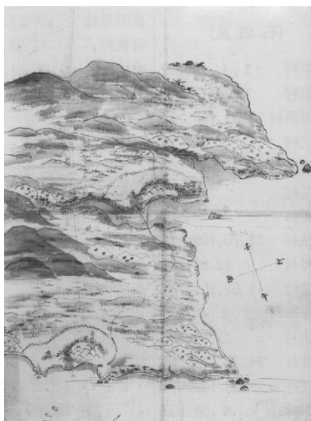
図5 「八重山古地図」にみる西表島南東部集落(仲間村・南風見村)を囲む防風線の外側に、大規模な猪垣を確認することができる。(沖縄県立図書館所蔵)。
