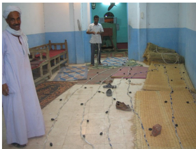
図 014 電灯設置風景 1
