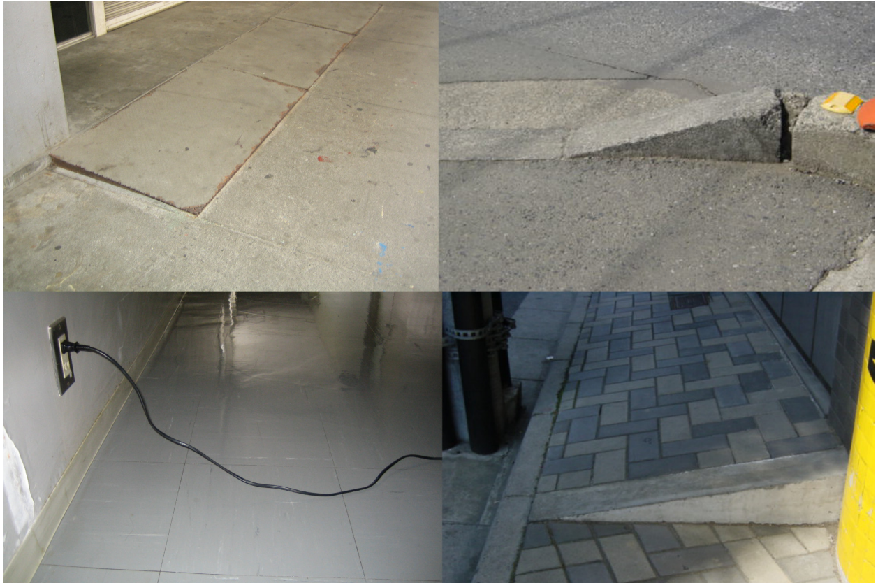
fig1-9 傾いた障害物の例
