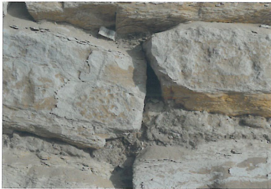
1 アブ・シール南丘陵南東裾野の石積み遺構 石材間のモルタル。石膏の結晶が見られる。
