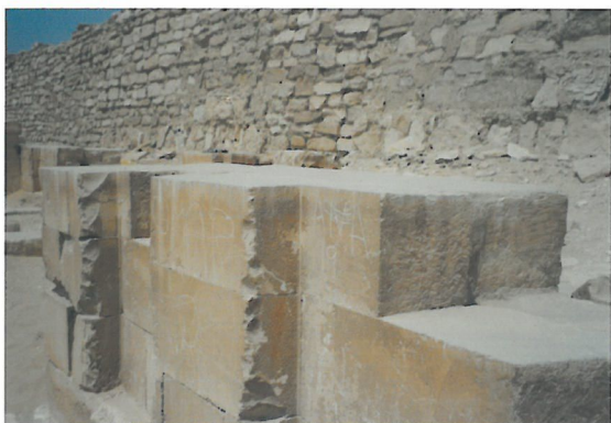
1 階段ピラミッド外周壁に使用されている 硬質白色石灰岩類似の石材
