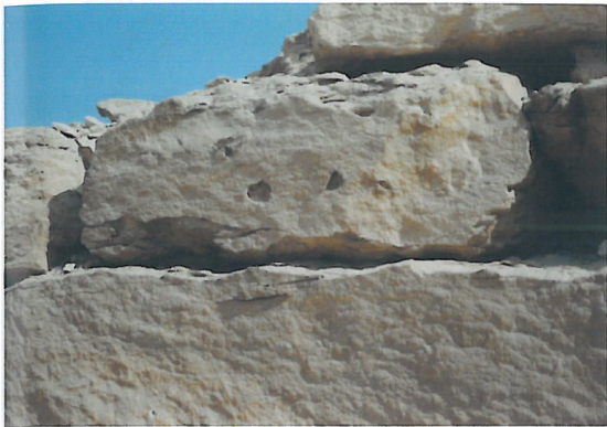
1 石灰岩表面に見られる石膏(サフラー王葬祭殿の壁)
