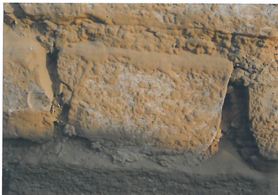
3 アブ・シール南丘陵南東裾野の石積み遺構 下部石材表面を覆う NaCl の結晶
