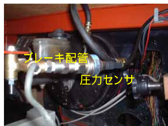
Fig.5-3-7 ブレーキ踏み込み圧取得のための圧力センサの取り付け
