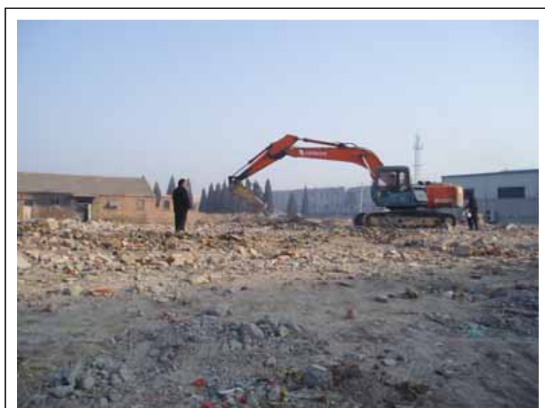
写真 1-1 農家屋敷が取り壊されているところ(2008 年 2 月)
