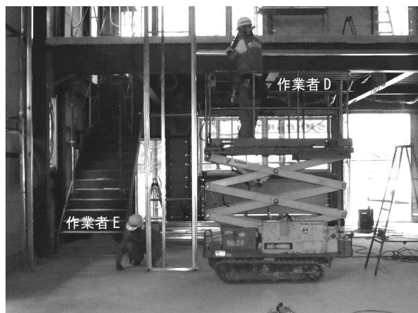
Figure 2.2.3 作業風景 1 (作業者 D および作業者 E)
