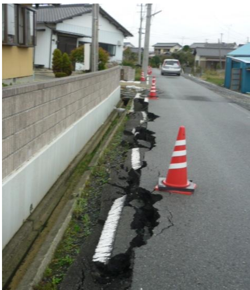
写真3 勿来地区安良町周辺の隆起した道路（2011年10月24日筆者撮影）
