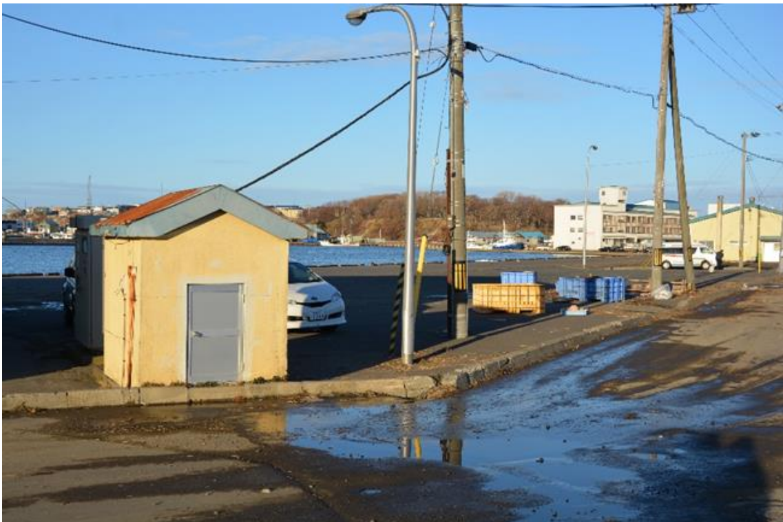
写真-2.6 高潮被害を被った2日後の根室港の様子
