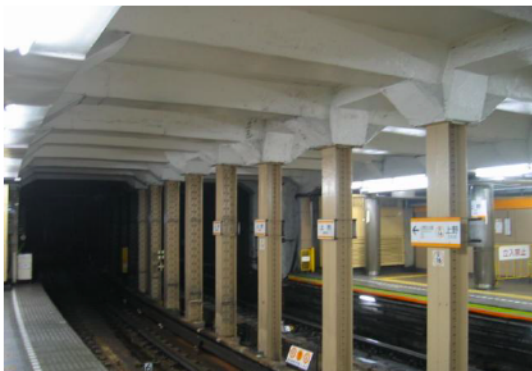
写真 2-1-2 上野駅の鉄構框構造 1)
