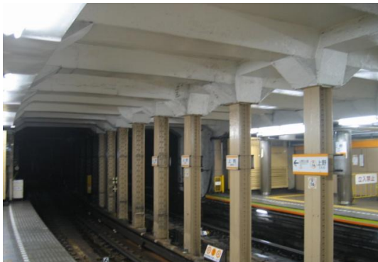
写真 1-2-1 鉄鋼枠構造(上野駅) 6)
