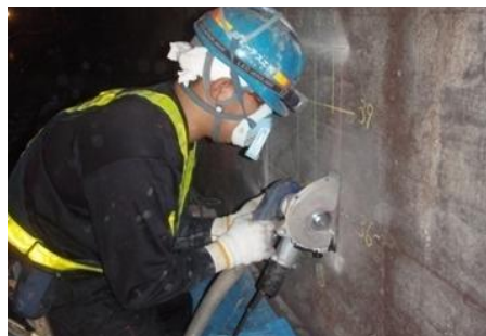
写真 3-2-1 はつり作業状況1
