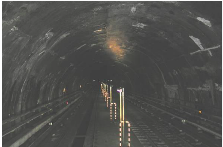
写真 2-1-4 末広町駅～神田駅間アーチ型トンネル 1 2)
