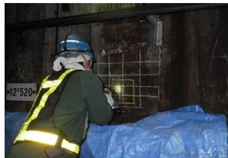
写真 3-2-2 はつり作業状況2
