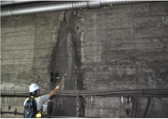
打音検査(側壁)
