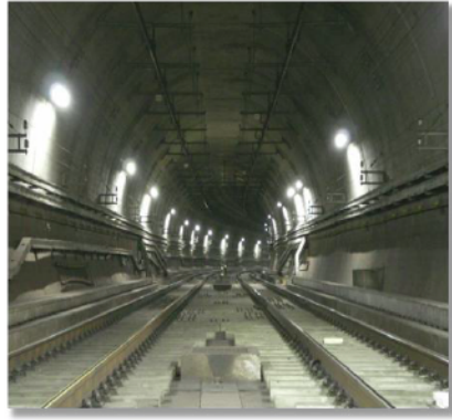
シールドトンネル
