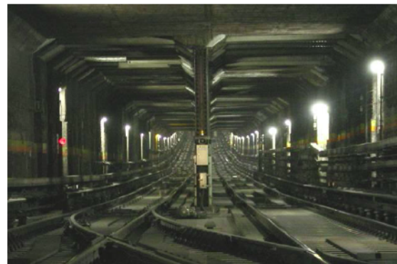
写真 2-1-3 神田駅～三越前駅間の鉄構框構造 1)
