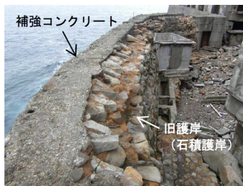
図-2.4 護岸の一例(天川および補強コンクリート：1897 拡張部)
