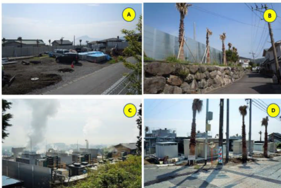
図3.6 住宅と接する温泉発電施設(2016年4月撮影)
