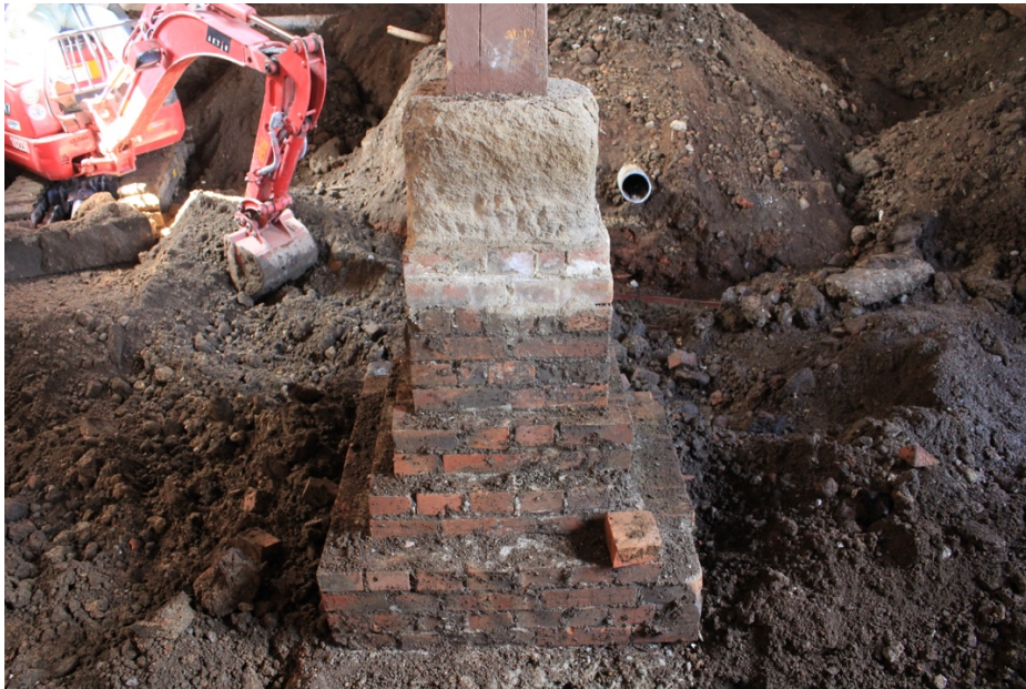
図 3.3 一階支柱・礎石の下部に積まれた根積み (該当ページ p.30 撮影野村渉 (早稲田大学建築学科学生))
