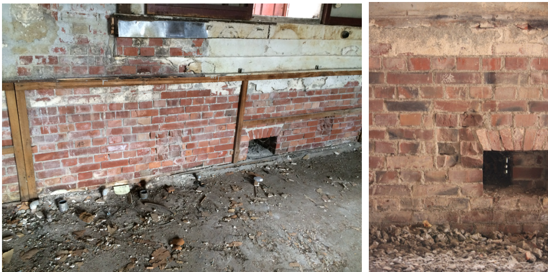
図 3.4 通気口近くに確認できる煉瓦の削り痕跡 (左)
