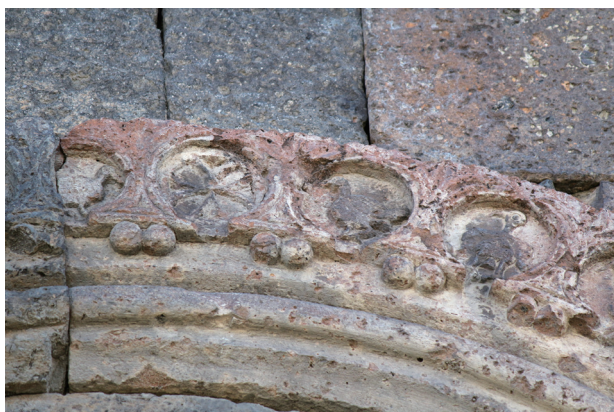
図15 北外壁、二連フード（左一部）
