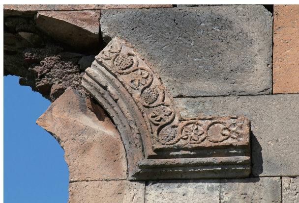
図9 南外壁、フード(中央・上部)
