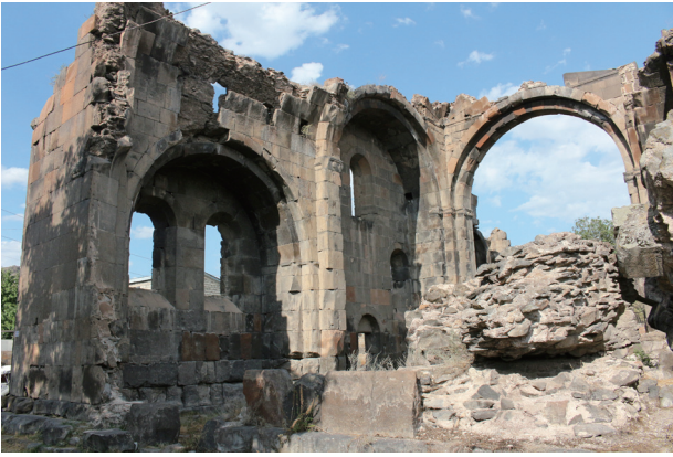
図19 教会堂内部（南西より）
