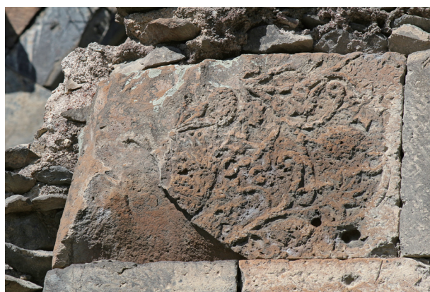
図10 南外壁、壁面(扉口右1)
