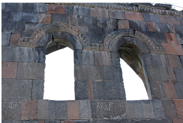
図14 北外壁、二連フード
