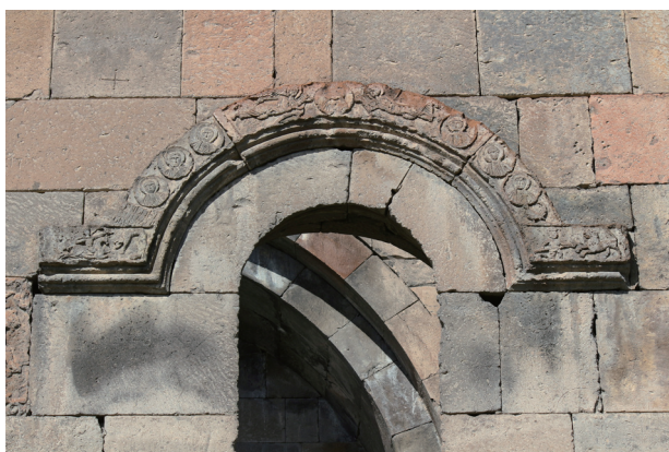
図3 南外壁、フード（扉口右）
