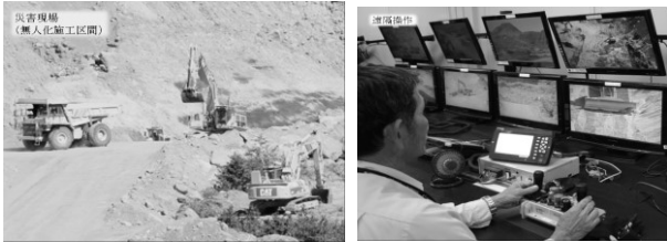
図1 無人化施工技術(建設機械稼働状況と遠隔操作状況)
