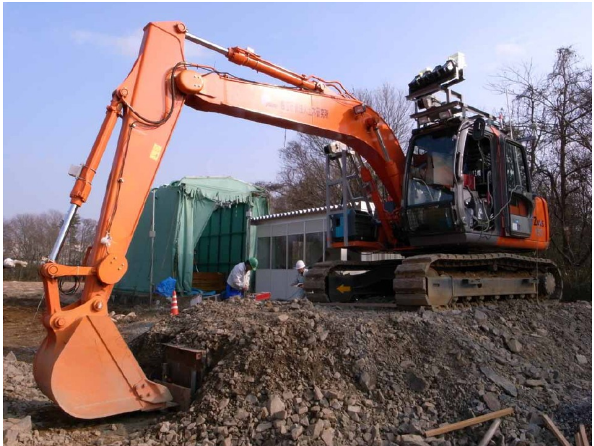
図 2.2 掘削作業時の建設機械の状態 (2013.3 茂木撮影)
