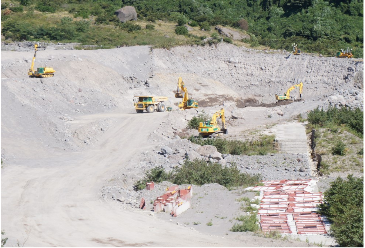
図 1.2 無人化施工による災害復旧状況（雲仙 2014.9 茂木撮影）
