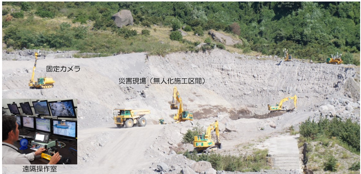
図 1.8 災害復旧現場での無人化施工のシステム構成
