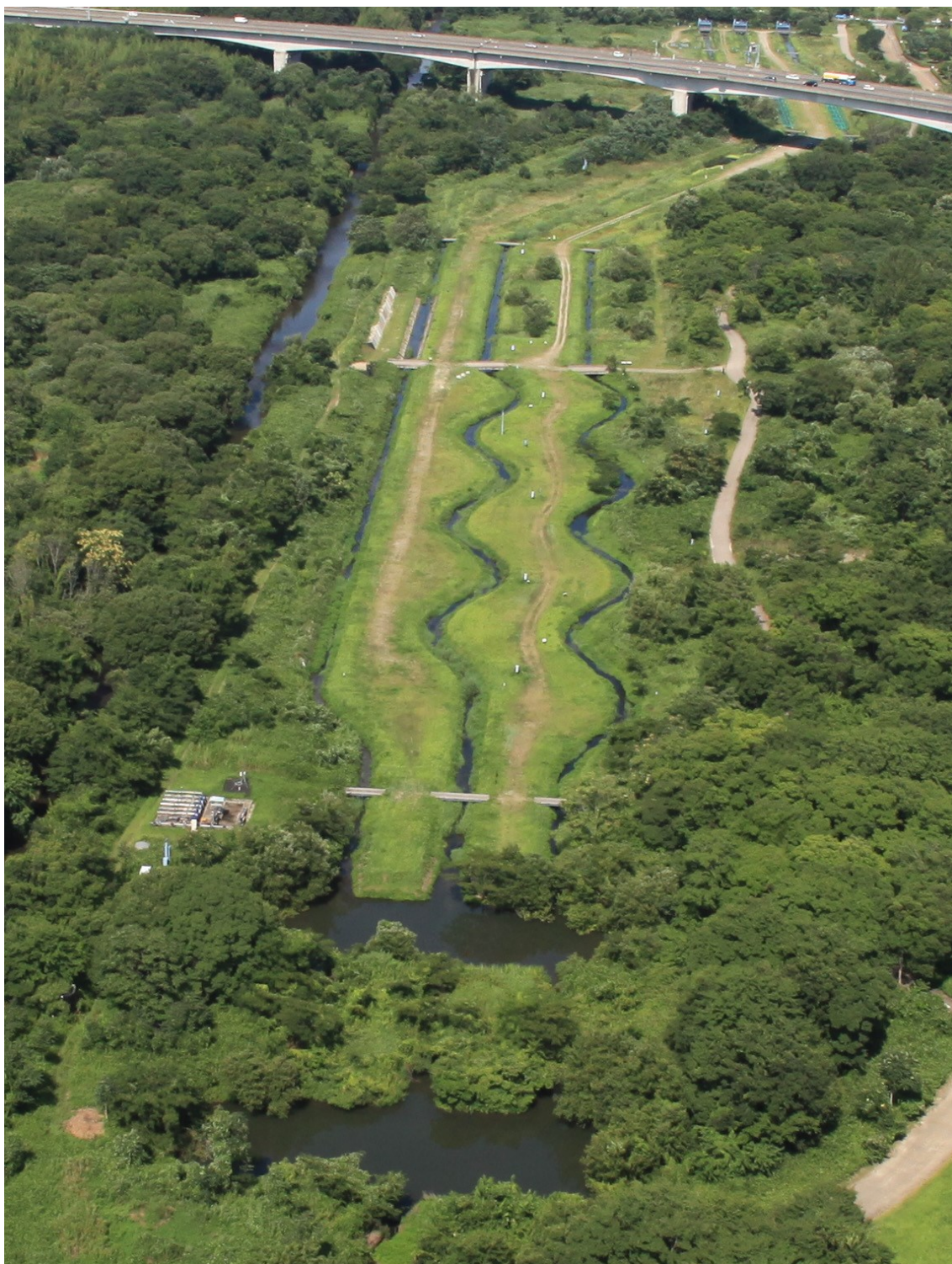
図-1 自然共生研究センターの実験河川 (出典：自然共生研究センター)
