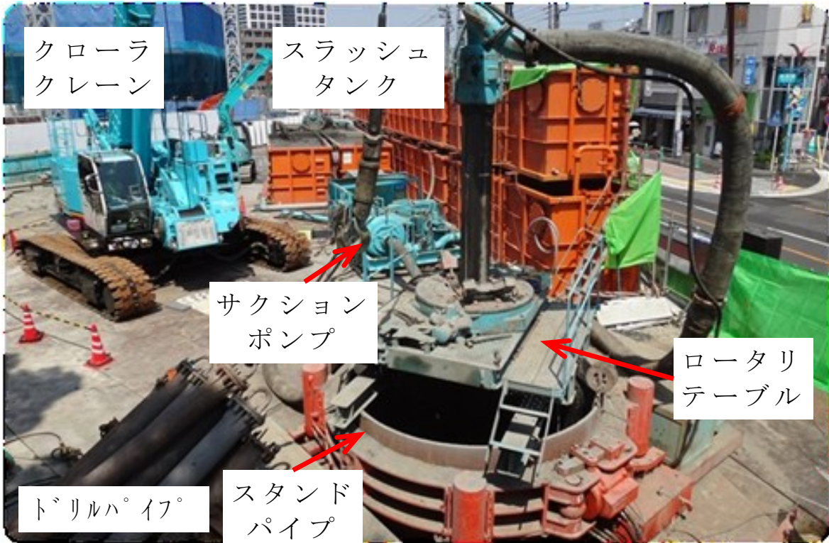
図 6-3-1 リバース工法施工概要図
