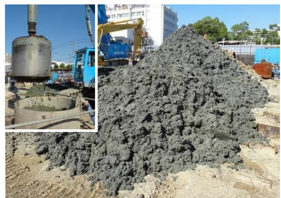
図 6-1-8 バケット引上げ掘削土
