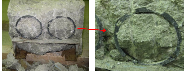
図 4-5-2 コンクリート置換充填状況
