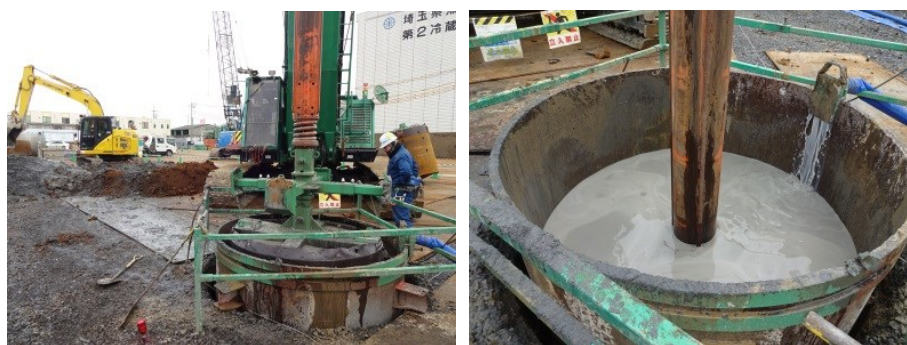
図 6-2-1 アースドリル工法施工状況
