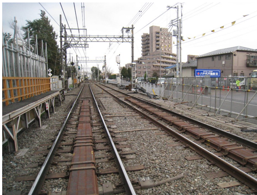
図 2.1.2-3 簡易工事桁設置状況
