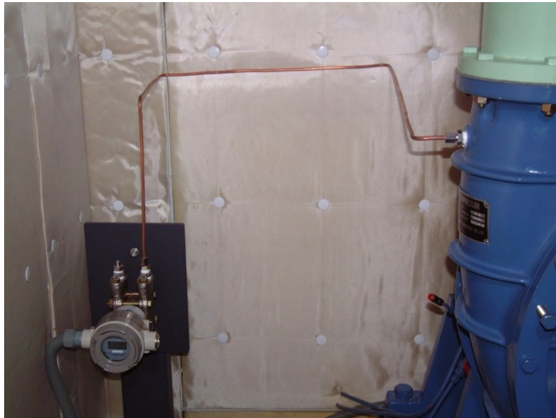
図 2.13 差圧発信器(圧縮機直後差圧)
